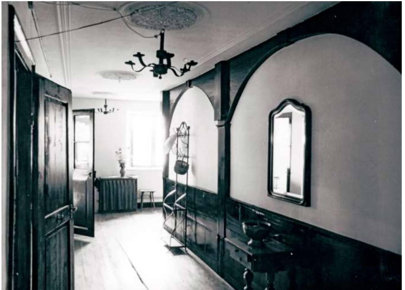
Ganggalerie im Obergeschoss mit Gipsstuckaturen an Decke für Sechsammlampen mit Kugelbirnen, 2 Holztüren Walter Gürtler hat das Holzwerk der Süd-, West- und Nordseite-Frauengalerie mit Gipsplatten abgedeckt, damit sein Wohnbereich akustisch und visuell vom Gottesdienstraum, seinem Atelier abgetrennt ist. Aus den Räumen der Judenschule hat er seine Küche und sein Wohnzimmer umgebaut und eingerichtet. Foto: Bernath, 1963
